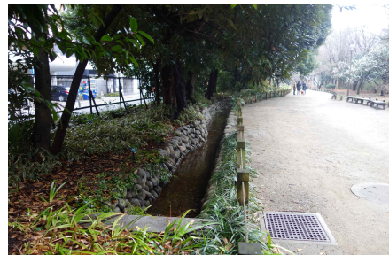
<산책로의 도랑 설치>
