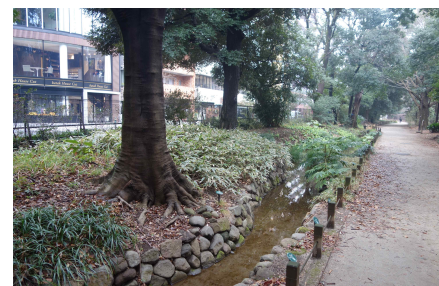
<산책로의 도랑 설치>
