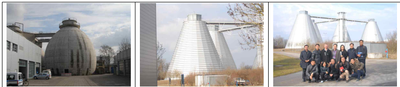
[그림 6] 뽀헨하수처리시설 과거 및 현재 시설 전경
