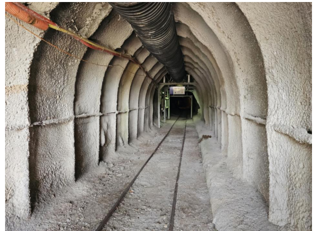
〈 터널 내부 진입로 〉
