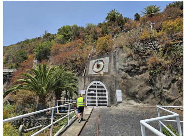
〈 터널 입구 전경 〉
