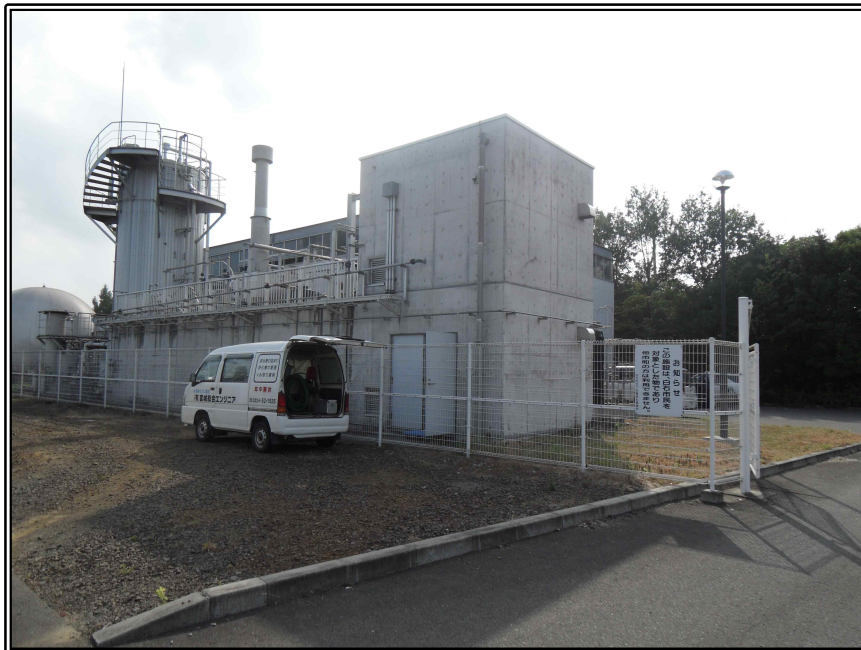
그림 18 시로이시시(白石市) 생쓰레기자원화 사업소 전경
