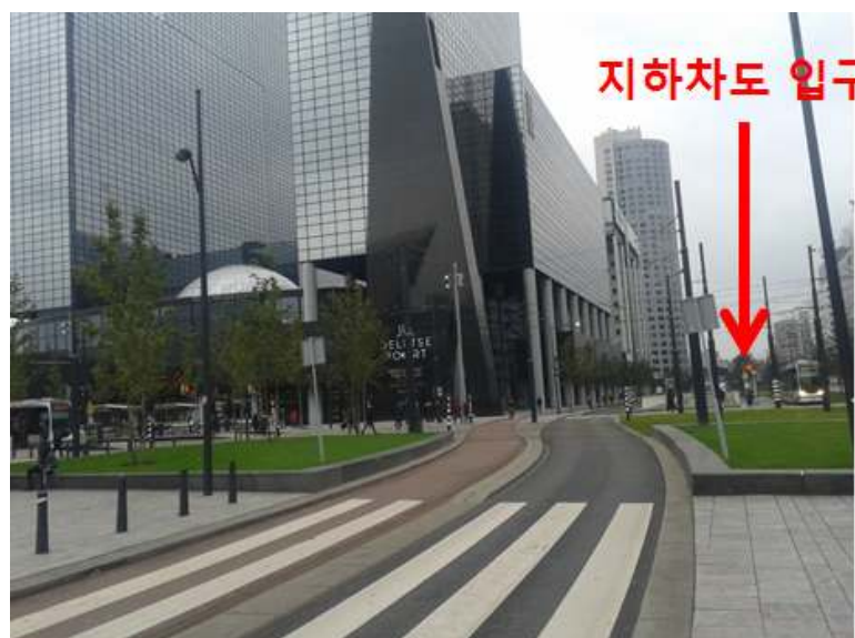
<그림 24> 로체르담 중앙역 앞 도로 및 교통류 지하 처리
