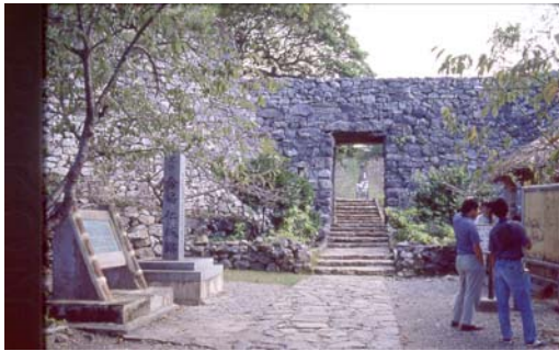
(사진 6) 나키징성 정면
