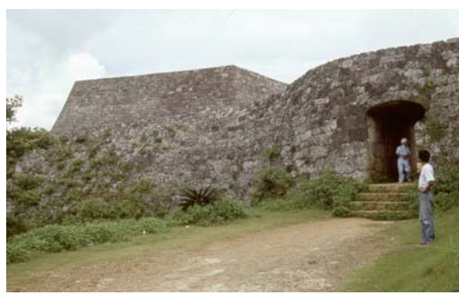
(사진 9) 자키미성 정면
