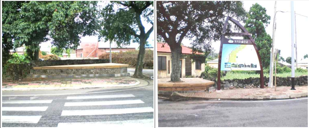
당초 1.2m 콘크리트 침터 정자→높이를 0.6~0.8m 낮춰 정비
